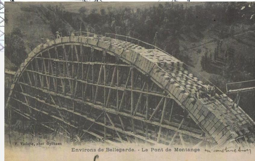
ce sable un petit barrage est établi en amont avec un couloir en planches pour effectuer le lavage et le tamisage. Les voûtellettes d'élévage sont construites de moellons piqués des carrières de Champfromier et du lit de la Valserine.
