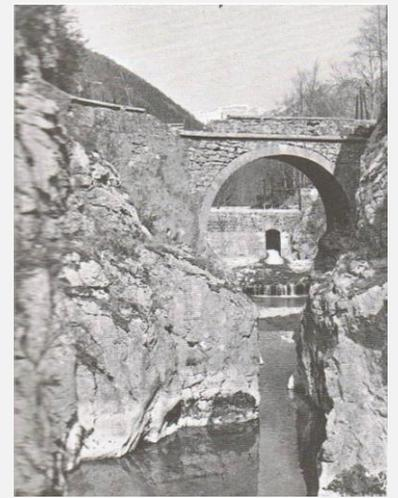
1910 : En amont du pont, un barrage a été construit pour alimenter l'usine électrique de Sous Roche qui va fournir l'électricité au tram Bellegarde Chezery.
